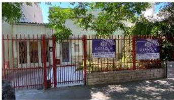
VILLA MARTELLI Casa 3 Amb.
