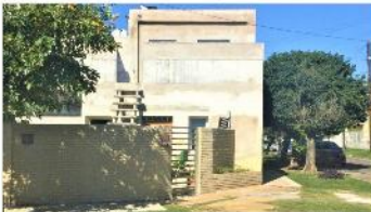
VILLA MARTELLI Casa 3 amb
