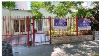
VILLA MARTELLI Casa 3 Amb
